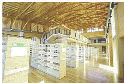
茂木町まちなか文化交流館 ふみの森もてぎ（栃木県茂木町）
