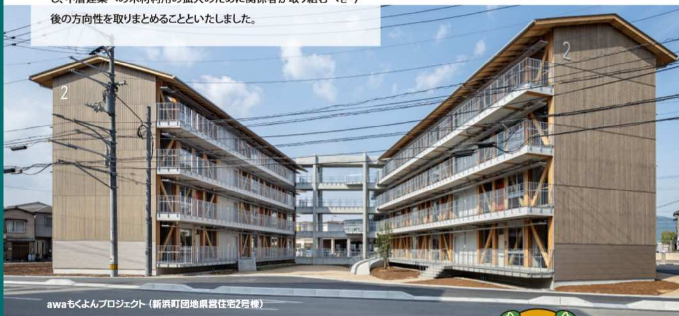
大断面製材による75分耐火構造柱の構築
